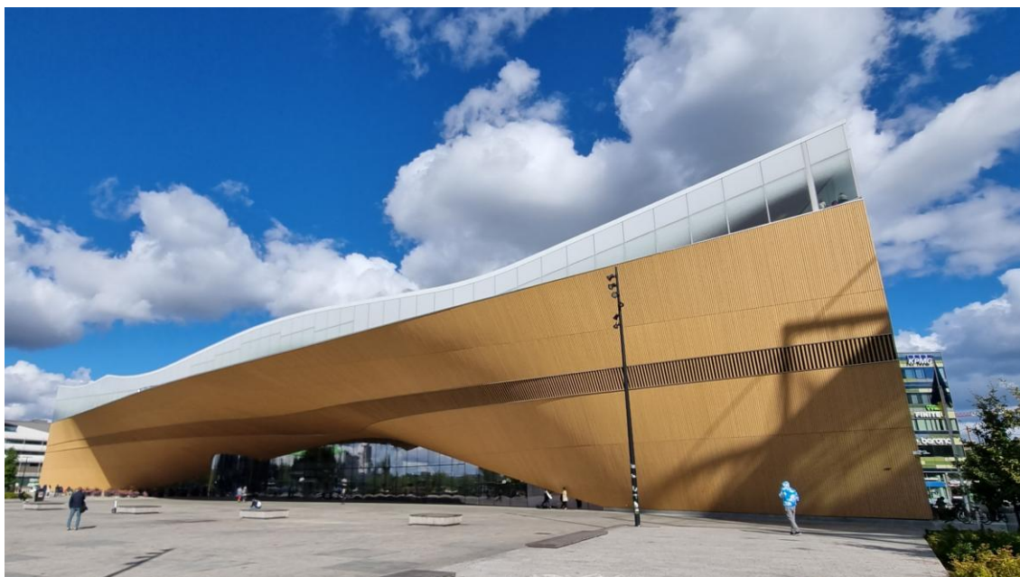
Biblioteca Central Oodi, Helsinki. Fachada principal.
